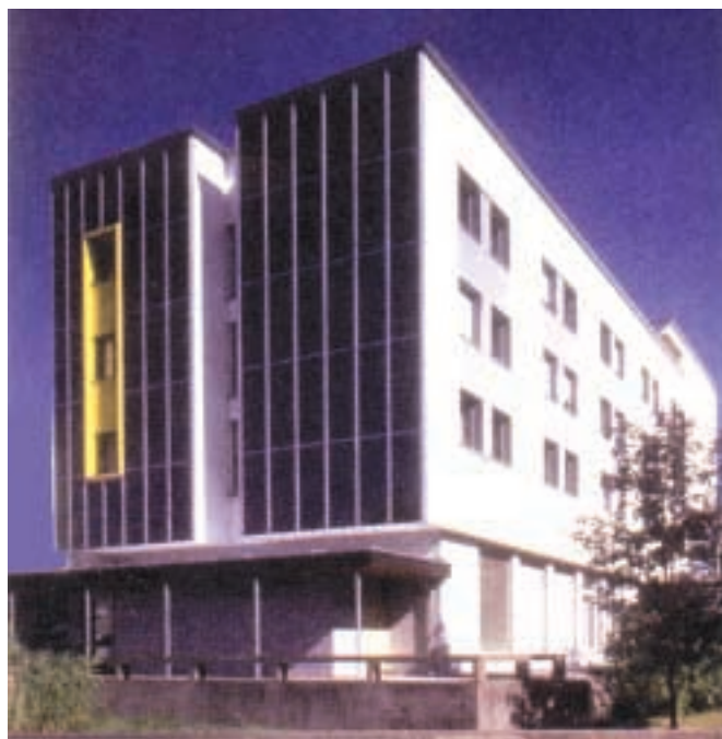
Immer wieder ein Ansporn: der Blick über den Bodensee, hier großflächige fassadenintegrierte Kollektoranlage am Kolpinghaus in Dornbirn
