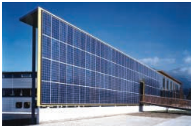
Ebenfalls in Vorarlberg: Große Fassadenintegrierte Photovoltaik- und Kollektoranlage am Energiepark West
