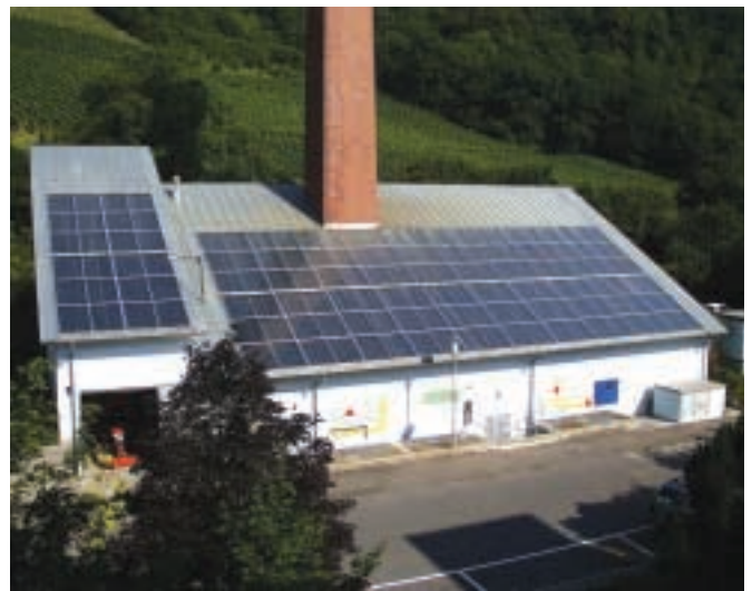
Eine der größten Kollektoranlagen im Hegau auf einem Dach des Hegau-Klinikums Singen
