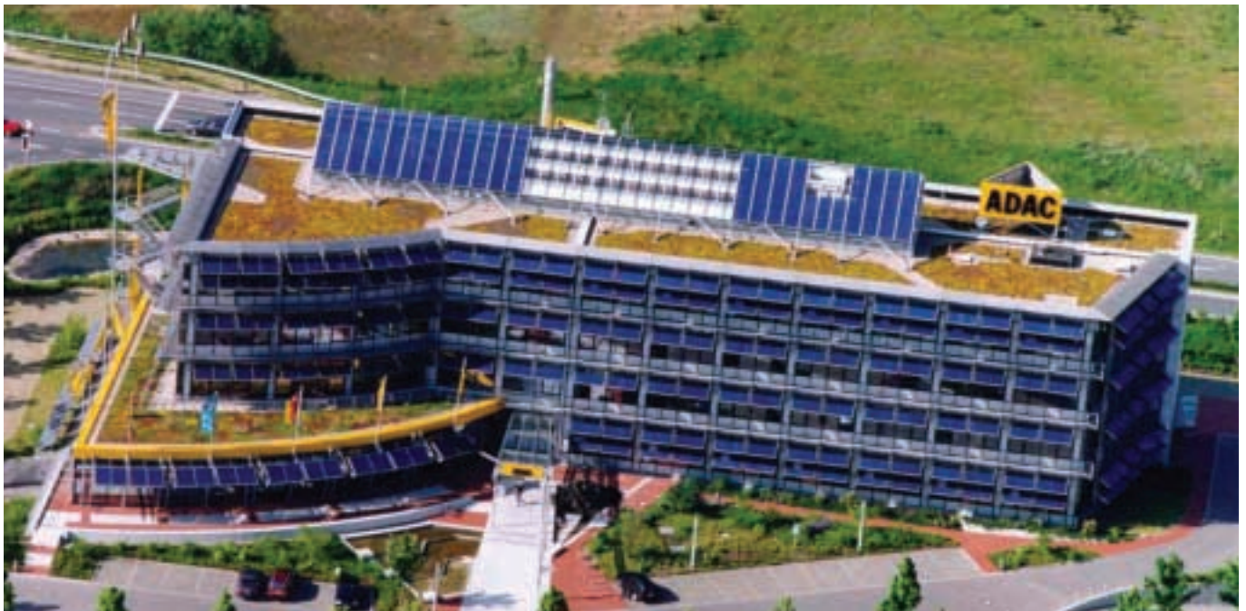
Fassadenintegrierte Photovoltaik-Module mit Doppelnutzen beim ADAC in Hannover: Stromerzeugung nach oben und sommerliche Abschattung nach unten 39
